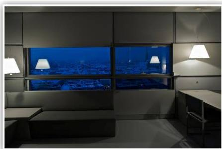
Die transparenten vierteiligen Fenster dieser ansonsten geschlossenen SSG Elementfassaden, Fassaden mit Sandwichelementen und innenseitigen Schiebeläden, welche in unterschiedliche Richtungen öffnen. Es entsteht so je nach Stellung der einzelnen Schiebeläden eine rechteckige oder kreuzförmige horizontal-gestreckte Öffnung, welche den Ausblick auf das Panorama des historischen Wiens und den Kahlen Berg rahmt.
