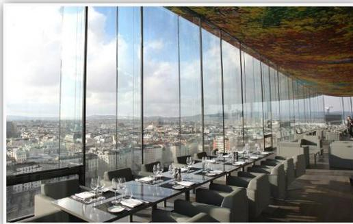
Die raumhohe, doppelschallige Fassade hat außenseitig eine 6 m hohe Einfachverglasung und innenseitig eine Isolierverglasung. In dem Zwischenraum wird die Fassade über Glasschwerter ausgesteift. Die beiden Glasebenen haben einen Abstand von ca. 80 cm, der Zwischenraum ist für Reinigung und Wartung begehbar.
